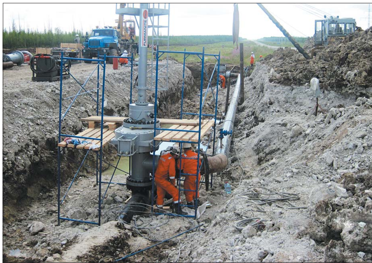
Новая технология позволила перекрыть участок трубопровода под давлением, без остановки перекачки нефти
